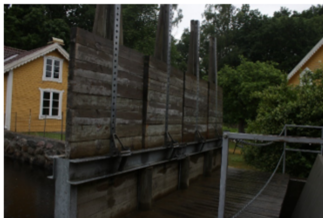
Figur 3: Bild på intagsluckor och intagsgaller vid Alsterbro övre vattenkraftstation, samt Thomas Sandbergs gula bostadshus i bakgrunden.
