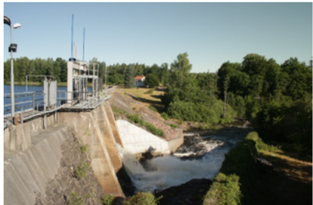
Figur 2: Bild på spillfåra och naturfåra vid Hornsö vattenkraftstation.
