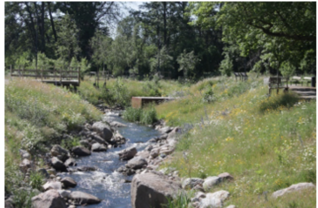
Figur 1: Bild på omlöp et vid Nykvarn, Linköping.
