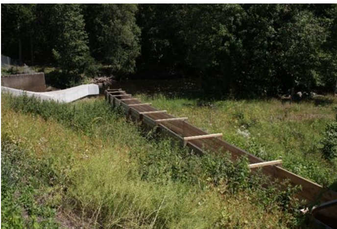
Figur 3 Exempel på flyktväg (trästrukturen, nedströmspassage) som rinner ut i naturfåra, bild tagen vid Skälleryd vattenkraftstation.
