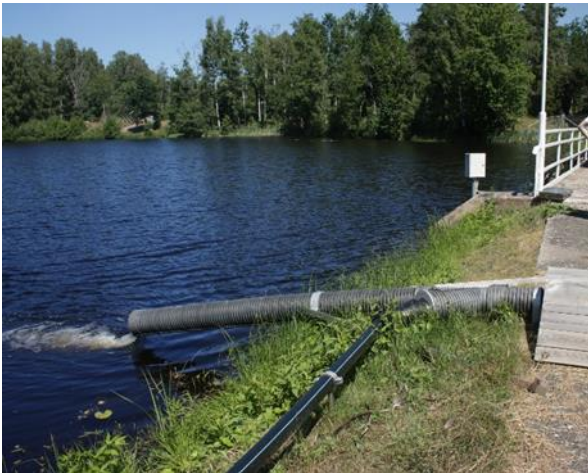
Figur 7 Exempel på ålyngelledare. Bild tagen vid Skälleryd vattenkraftstation
